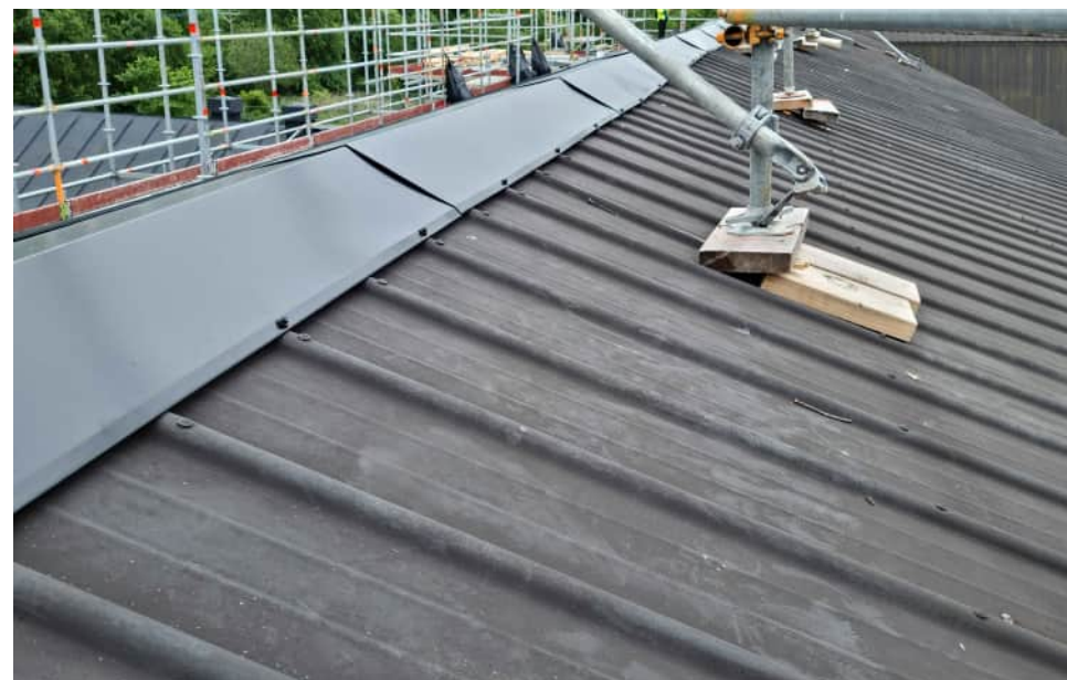
Övre bilden visar mötet mellan de två aktuella takfallen efter den nya plåten kommit på plats. Nedre bilden visar den luftade övergången mellan den nya nockplåten och den äldre pannplåten, här östra längans västra takfall sett mot söder.
