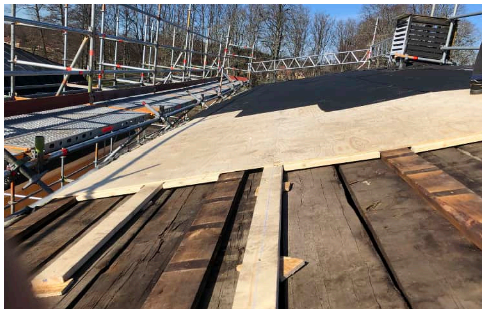
Övre bilden visar södra takfallet med arbetet påbörjat i väster. Nedre bilden visar hur underlaget för papp och plåt stagats upp för att minimera åverkan på takets underbrädning. Foto: Dick Sandberg.
