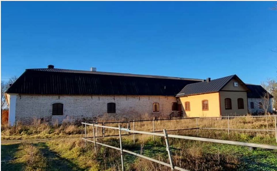
Övre bilden. Södra fasaden innan åtgärd. Den övre delen av det brutna takfallet kom att förses med ny plåt med solcellsfilm. Nedre bilden visar östra fasaden innan åtgärd, även här försågs takfallets övre del med ny plåt och solcellsfilm.
