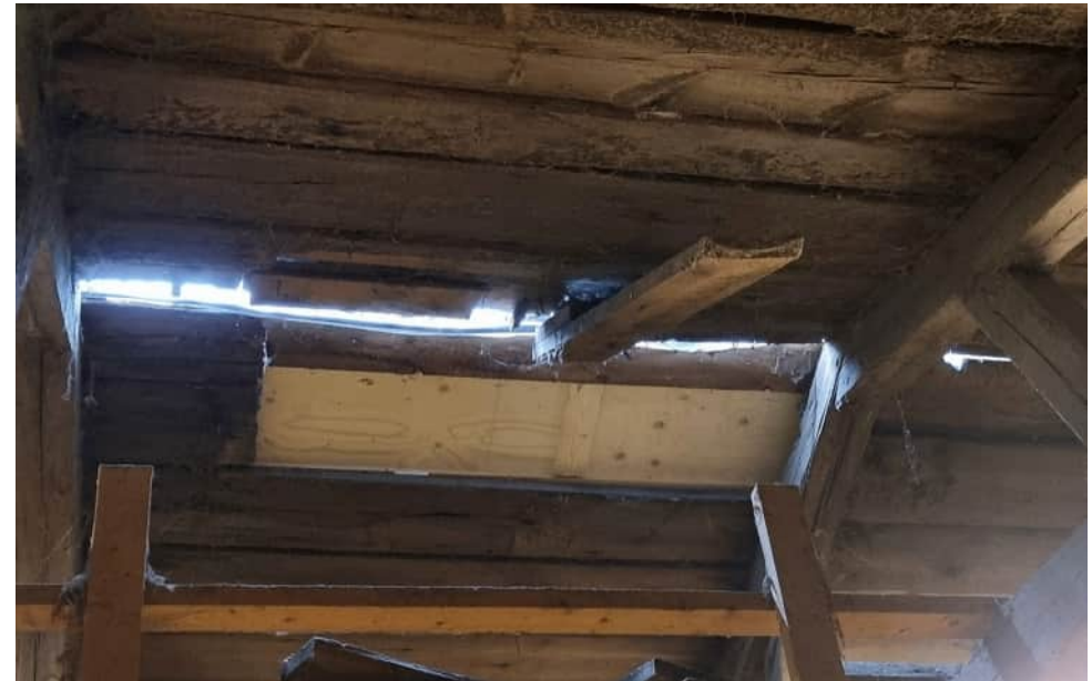
Övre bilden, detalj av genomföring av kablage i läget som ses på övre bilden i mitten, nätet som tillkom i nock kan skönjas i bilden. Förvånansvärt lite av den äldre underbrädningen behövde ersättas. Nedre bilden visar enda ställen där virke avlägsnats.
