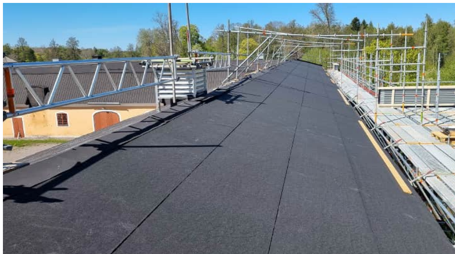
Överst 3:e från vänster, bärlinorna fortsätter in i nästa sektion, med pågående läggning av plywood och papp. Överst till höger, papp färdig att rullas ut på den färdigspikade plywooden. Foto: Holmgrens Bygg AB. Nederst, östra takfallet papptäckt.
