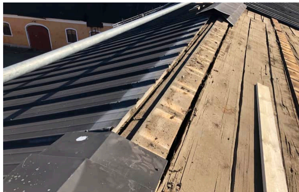
Övre bilden, pannplåten är fäst i relativt glesa bärlinor som ger en luftspalt mellan takplåten och den välluftade underbrädningen. Nedre bilden visar dels gliporna i underbrädningen, dels kan man ana att nocken bidragit till att ventilerade vinden. Foto: Dick Sandberg.
