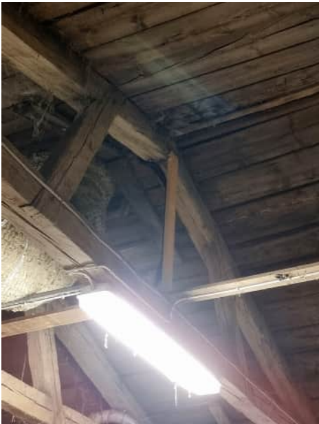
Överst till vänster, övergången mellan skiljevåg och underbrädning på östra vinden, överst i mitten samma övergång med dragning av kablage för solceller. Nedre bilderna visar ny stående kabelbräda till vänster och ny håltagning för kablar till höger.
