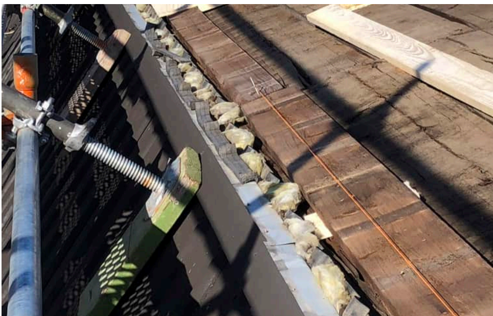
Övre bilden, pannplåten från 1986 inför fortsatt demontering. Nedre bilden, detalj av mötet mellan plåten mot det nedre takfallets plåt efter demontering av plåt på övre takfallet. Foto: Dick Sandberg.
