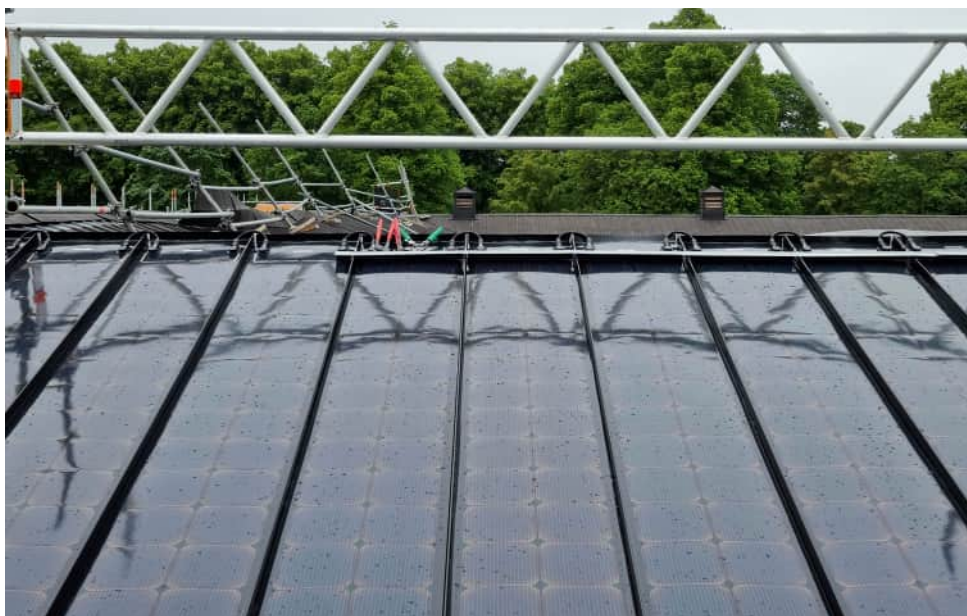
Övre bilden visar papptäckt sarg i mötet mellan de två aktuella takfallen. Nedre bilden visar pågående arbete med koppling av solcellsfilmernas elektronik och montering av kabelränna.
