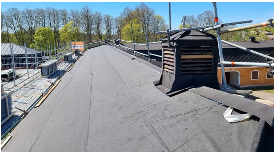
Överst 1:a från vänster, nya bärlinor monteras, anpassade i höjd för att jämna till det böljande takfallet. Överst 2: från vänster, arbete pågår med montering av plywood. Foto: Holmgrens Bygg AB. Nedre bilden visar södra takfallet inför plätläggning, med takpapp lagd.
